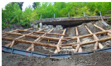
Abb. 71: Ausfachung mit Distanzhölzern (Ammann Ingenieurbüro AG)
