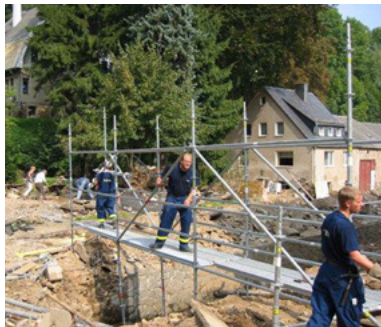
Abb. 93: Trümmersteg mit EGS (THW)
