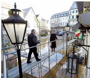
Abb. 94: Hochwassersteg mit EGS (THW)
