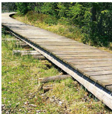
Abb. 83: Konstruktion mit Querbalken (ASTRA)
